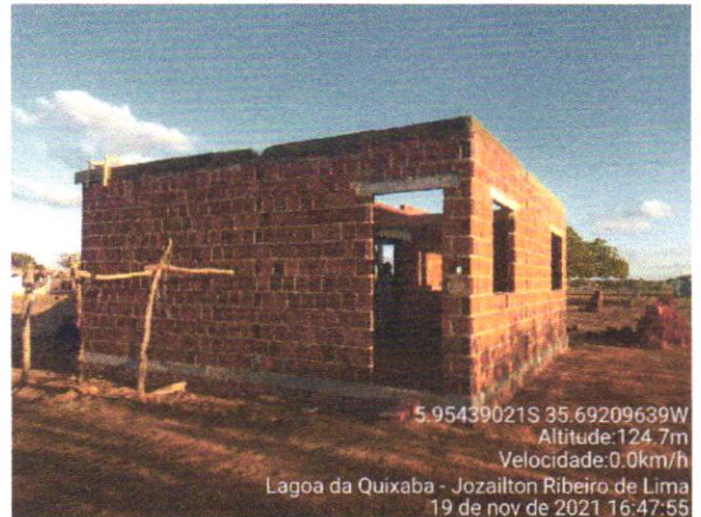
INICIO DAS CONTRUÇÕES DO PNHR NO MUNICIPIO.
